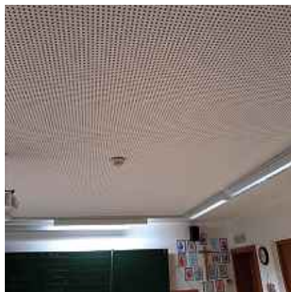
Akustische Sanierung in der GS St. Peter
