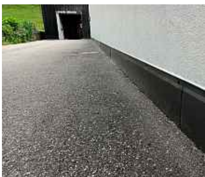
St. Johann Mittelschule neue Sockelbleche in Corten
