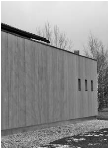
Der neue Probe- und Lagerraum
