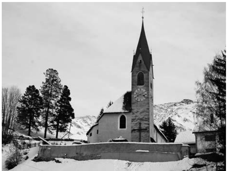
Neu sanierte Friedhofsmauer in St. Peter
