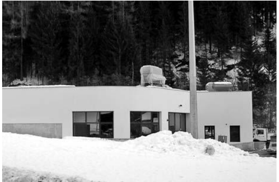
Der neue Gemeindebauhof zwischen Steinhaus und St. Jakob
