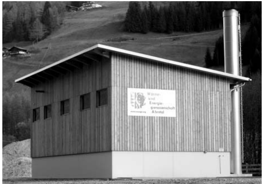
Fernheizwerk in Steinhaus
