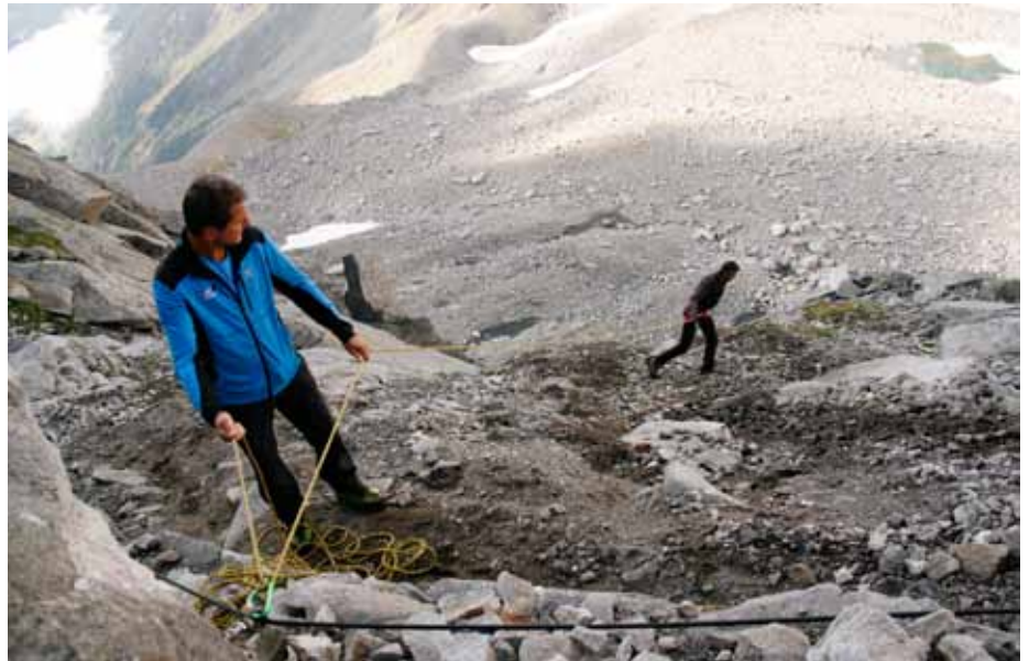
Arbeiten am „Kamin
