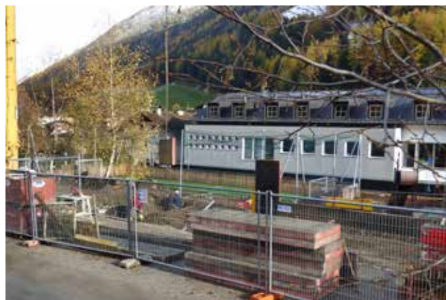
Hier entsteht die neue Kitas in St. Johann
