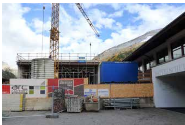
Umbauarbeiten bei der Mittelschule St. Johann
