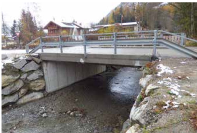
Brückenbau über den Wollbach in St. Jakob
