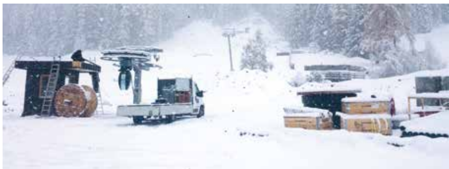
Letzte Arbeiten beim Liftbau
