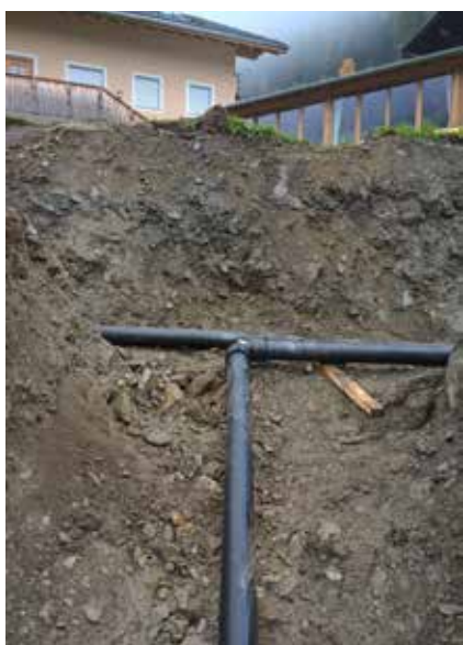
Zusammenschluss von Wasserleitungen in St. Jakob
