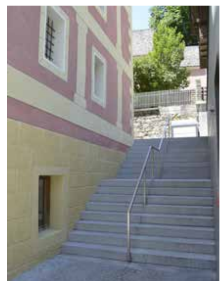
Treppe beim Bergbaumuseum saniert
