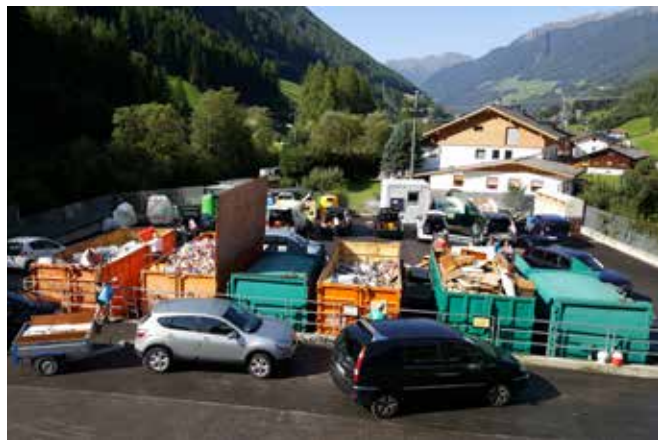
Das Bauhofsareal wurde neu asphaltiert
