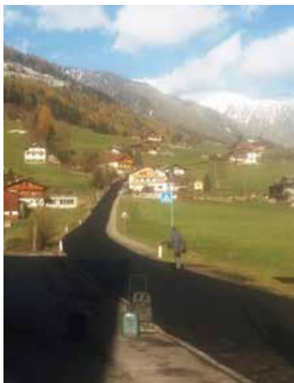
Neu asphaltierte Straße Kreuzwirt - Kordiler in St. Jakob
