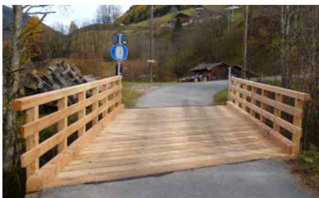
Keschmairbrücke über den Bärenalbach in St. Jakob saniert
