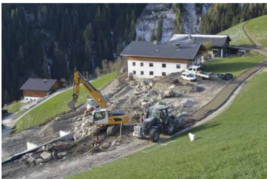
Sanierung Straße Schöllberg
