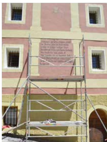
Malerarbeiten beim Bergbaumuseum
