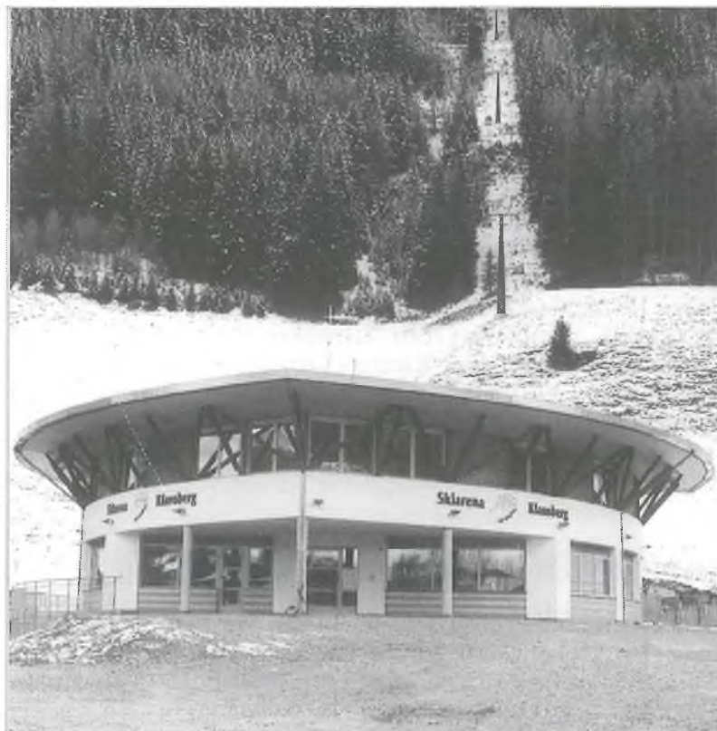
Das neue Gebäude an der Talstation Klausberg
