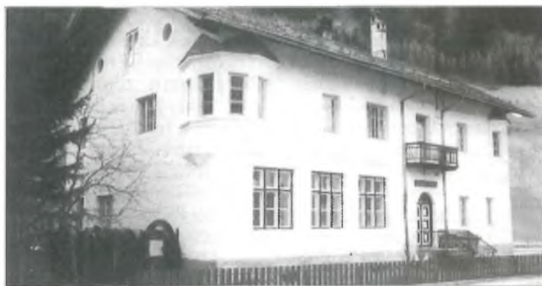
Die alte Volksschule von Steinhaus, das neue Kultur- und Jugendzentrum.
